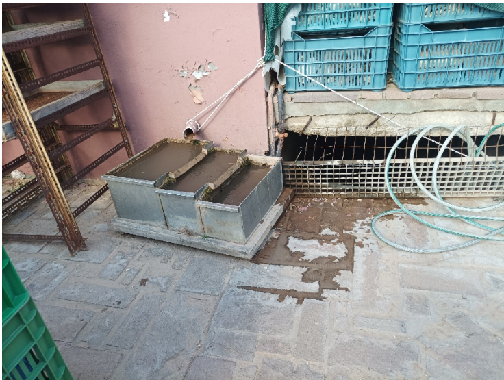
Εικόνα 7: ενδεικτικές διατάξεις (δεξαμενές) για την κατακράτηση του χώματος.
